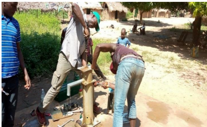
Réparation d'une pompe, Haut-Mbomou 2026, COOPADEM
